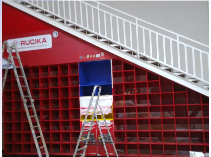
PEMBUATAN DAN PEMASANGAN RAK DISPLAY SALAH SATU TOKO RUCIKA DI TEBING TINGGI
