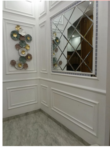
PEMASANGAN MOULDING DINDNG DENGAN CERMIN WAJIK EDGING SERTA LIS ALUMUNIUM
