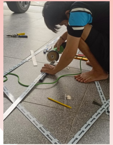
PEMASANGAN MOULDING DINDNG DENGAN CERMIN WAJIK EDGING SERTA LIS ALUMUNIUM
